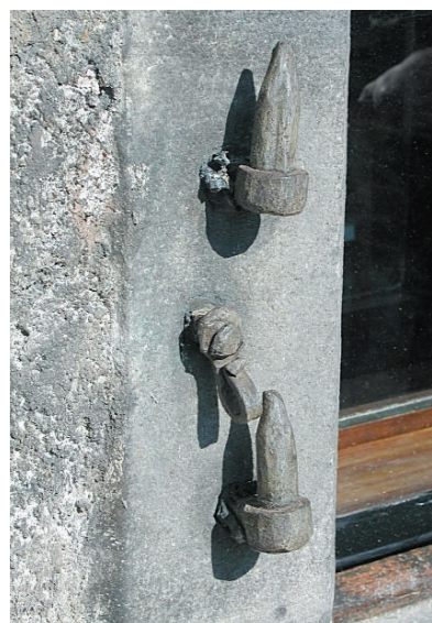
Obr. 24. Český Krumlov, státní hrad a zámek, detail kovaných trnů na zavěšení parapetní okenice po restaurování. (Foto Václav Girs, 2003)
