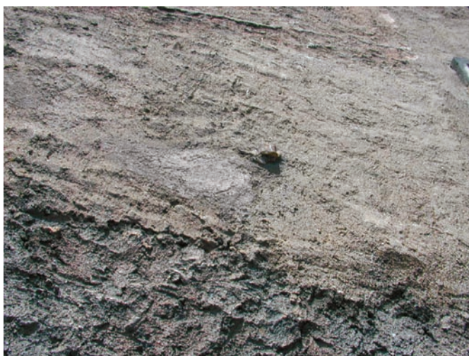
Obr. 27. Český Krumlov, státní hrad a zámek, střední část průčelí po restaurování s obnovou omítek nad skalním výchozem v místě odstraněného torkretu. (Foto Věroslav Škrabánek, 2005)
